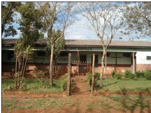
Foto 490. EMEF José Bonifácio desativada em Rincão dos Moraes.
