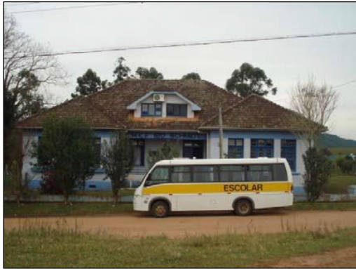
Foto 506. EMEF de Guassupi.
