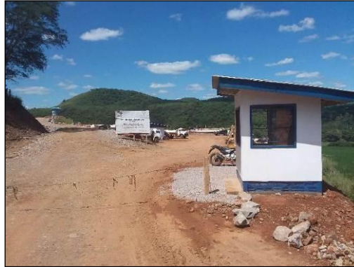
Foto 545. Canteiro de obras da PCH Rincão de São Miguel.
