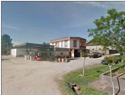
Foto 520. Acesso a Vila Block, São Sepé.
