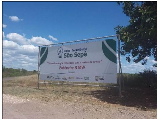
Foto 548. Usina termelétrica de São Sepé.
