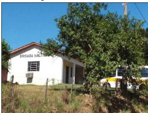
Foto 519. Posto da Brigada Militar na localidade do Arenal, Santa Maria.
