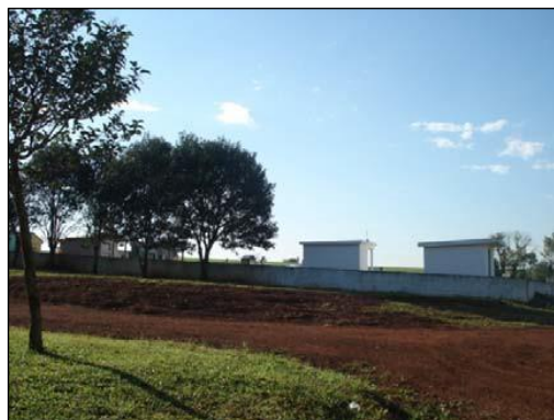
Foto 468. Cemitério da localidade de São José.
